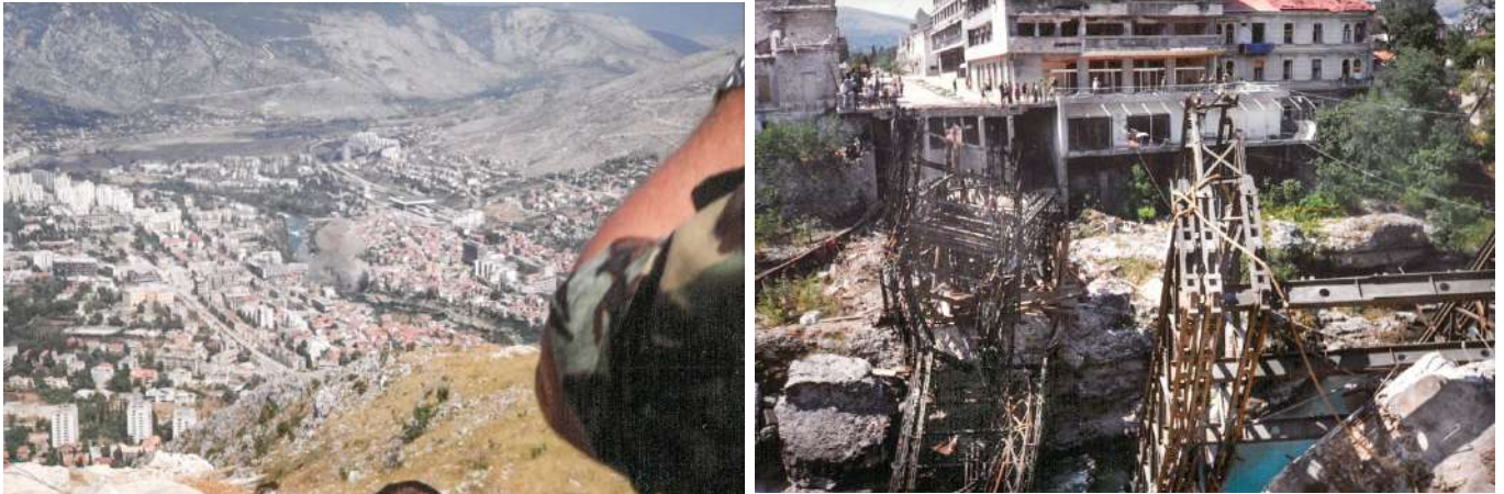
Voladura del puente de Tito
