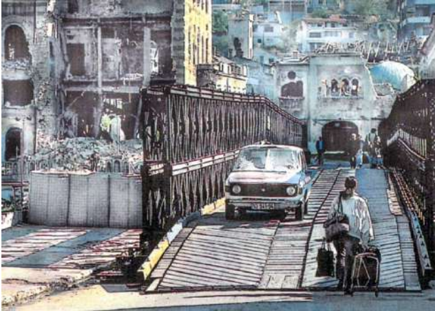
Nuevo puente Bailey
