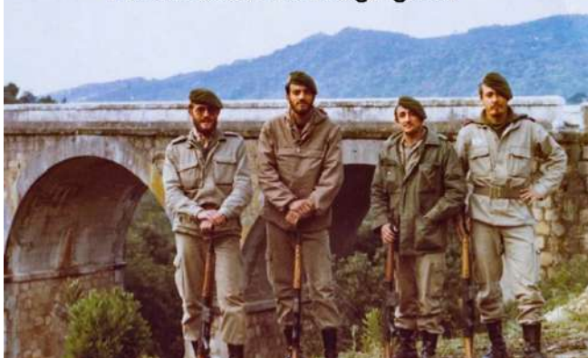
Puente sobre río Hozgarganta
