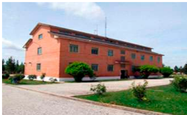
Edificio COE 61 en la Base del Cid
